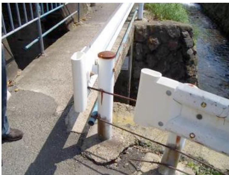
2009年7月23日現在：ガードレール端にゴムのカバーが取り付けられていた。
